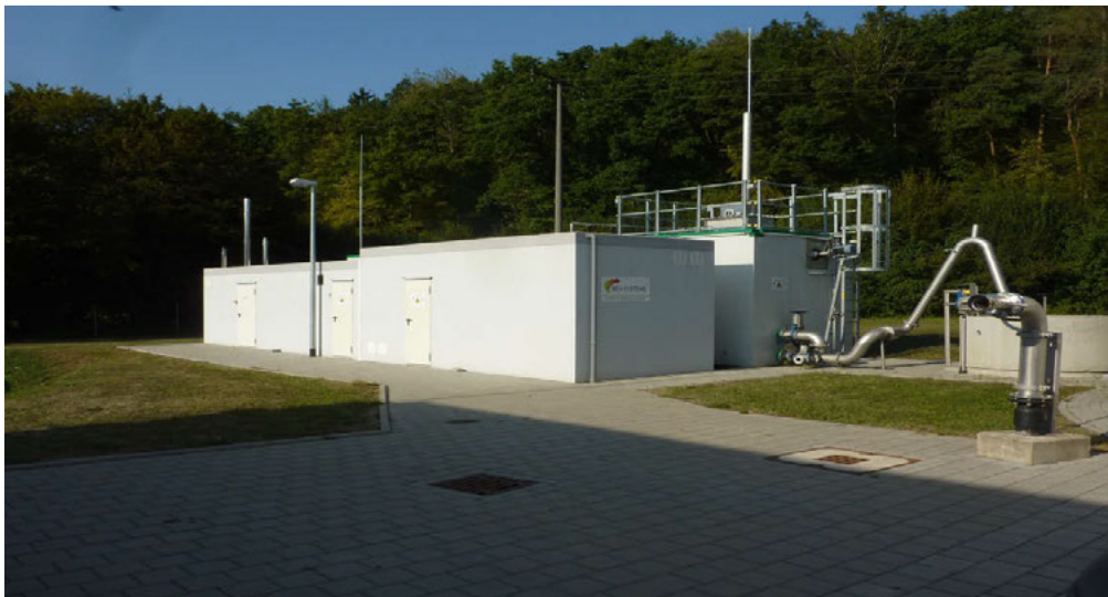
Bild 3: Einstufige modulare Kompaktfäulung der KA Steinfeld-Hausen
