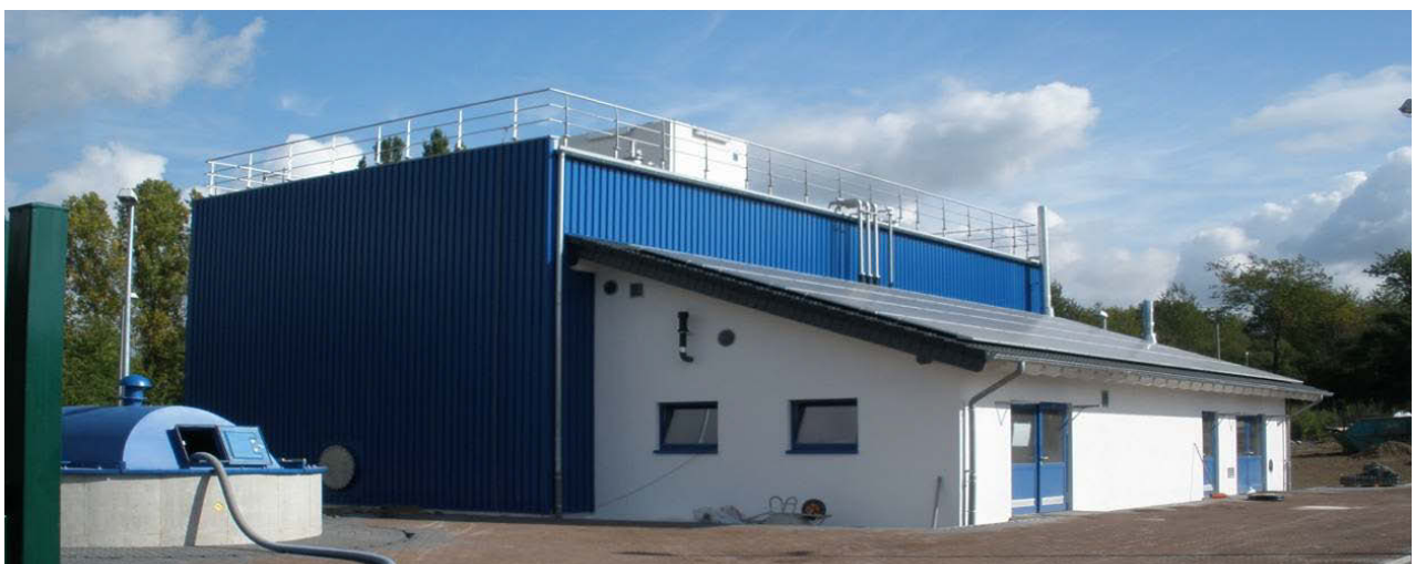
Bild 30: Kompaktfaulungsanlage auf der Kläranlage Linz-Unkel
